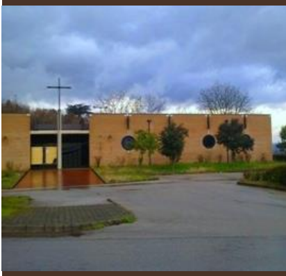
CHIESA S. PIO – ATRIPALDA PROSPETTO PRINCIPALE
